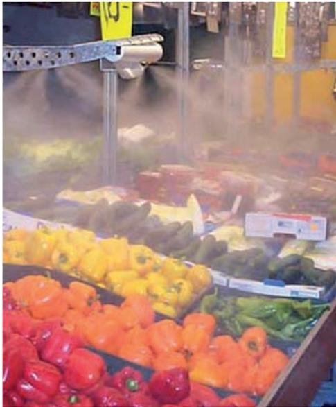
La brumisation haute pression **DID Clim** permet une humidification efficace de l'air ambiant. L'évaporation des micro-gouttelettes d'eau diffusées par brumisation assure une augmentation de l'hygrométrie générale.
